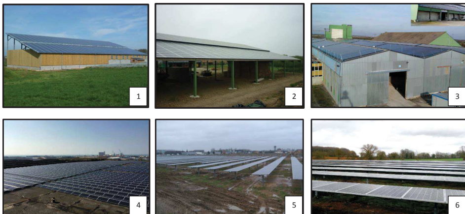
Figure 9 : Photographies des centrales solaires photovoltaïques exploités en toiture et au sol par IEL :
