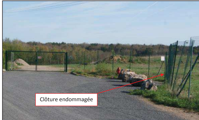
Figure 155 : Clôture actuelle du site
